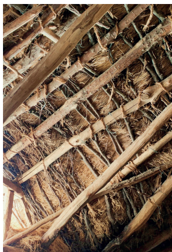
Figura 2: Detalle de la estructura interior de un techo, con las vigas, los cangos y los bilortos, en La Omañuela (desaparecida en febrero de 2025).
