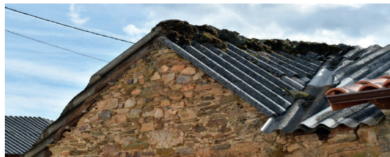
Figura 5. Construcción cubierta de techo y fibrocemento, rematándose la cumbre con tapines, en Carrizal de Luna. Fuente: Foto del autor
