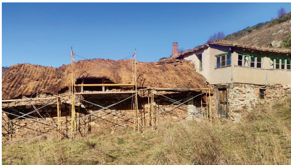
Figura 6: Retirada del fibrocemento de un pajar en La Omañuela, en febrero de 2025 (ya desaparecido)
