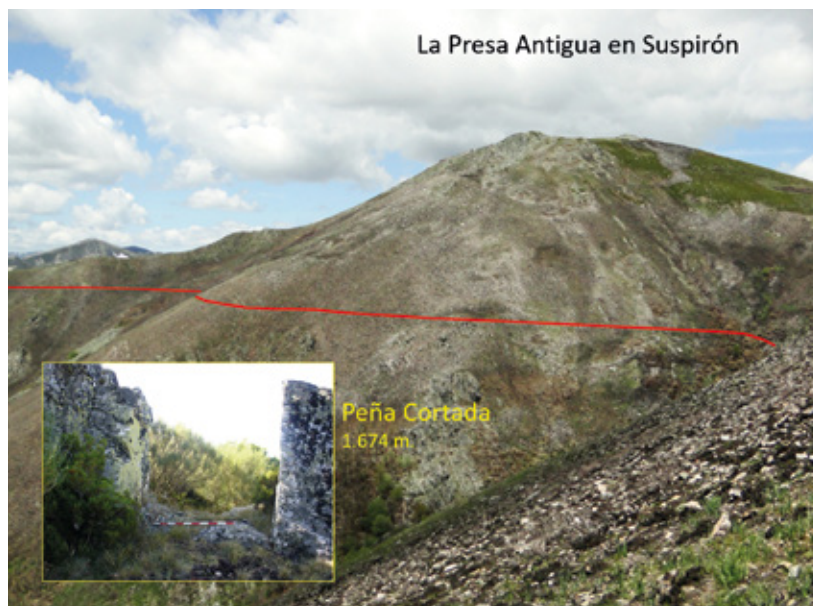
Figura 7.- La Presa Antigua en el Suspirón y detalle de Peña Cortada. Foto: M. Luz González.
