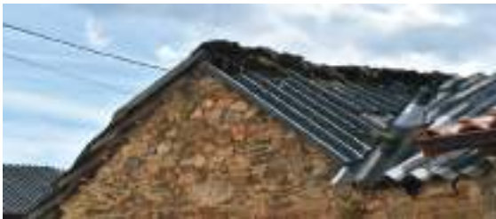
Figura 5. Construcción cubierta de techo y fibrocemento, rematándose la cumbre con tapines, en Carrizal de Luna. Fuente: Foto del autor
