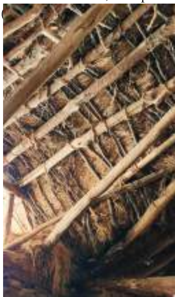
Figura 2: Detalle de la estructura interior de un techo, con las vigas, los cangos y los bilortos, en La Omañuela (desaparecida en febrero de 2025).
