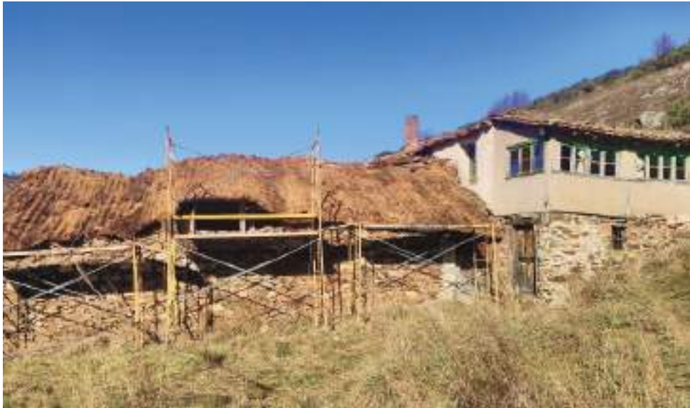
Figura 6: Retirada del fibrocemento de un pajar en La Omañuela, en febrero de 2025 (ya desaparecido)
